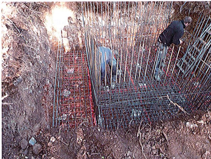
Le massif : les ouvriers en train de le ferrailer
