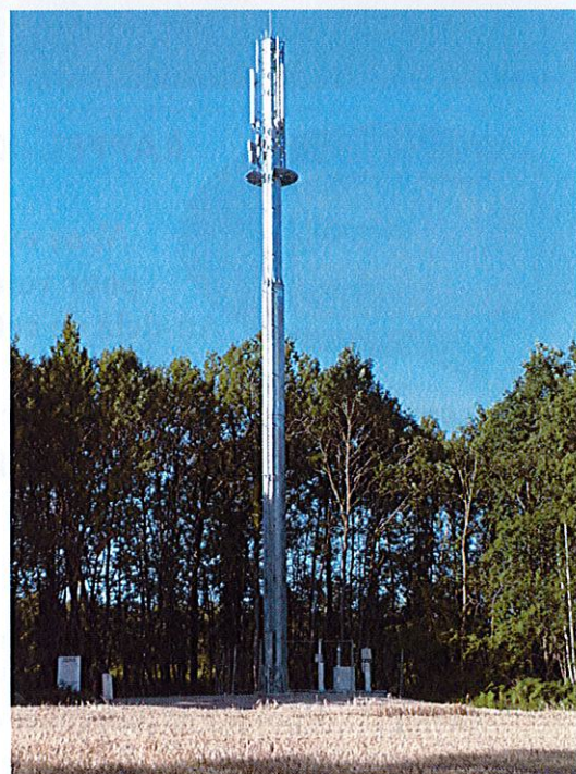
Le pylône de 31 ml de long et son poids est de 11 tonnes
