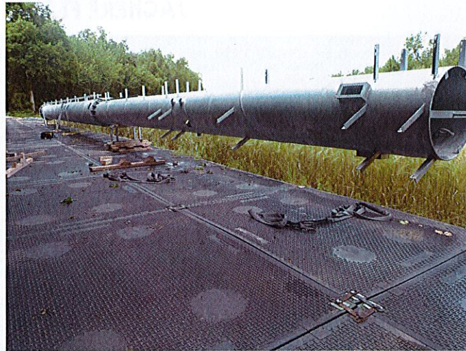
Le pylône de 31 ml de long et son poids est de 11 tonnes
